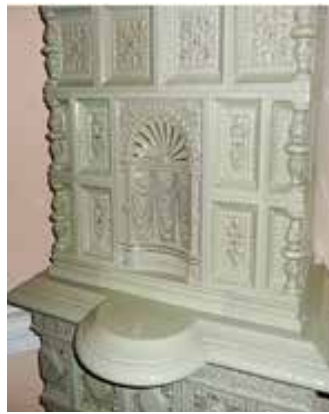
Рис. 11. Піч у будівлі резиденції виборзького губернатора, м. Виборг
